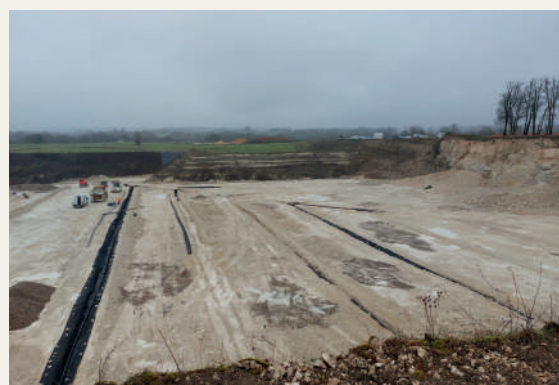
Création des tranchées des eaux de drainage du casier 17B
