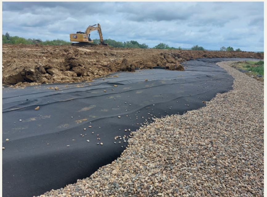
Mise en place d'un dispositif d'étanchéité par géomembrane.
