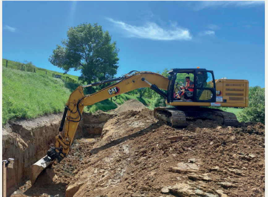
Création d'un fossé des eaux externes autour du site.
