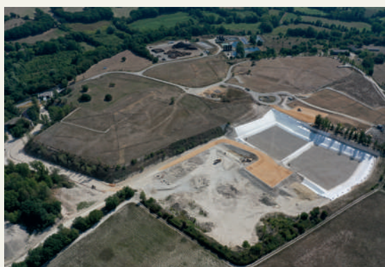
Vue aérienne des travaux finis
