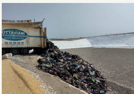
Septembre : Ouverture du casier B1 sur l'ISDND de Monflanquin
