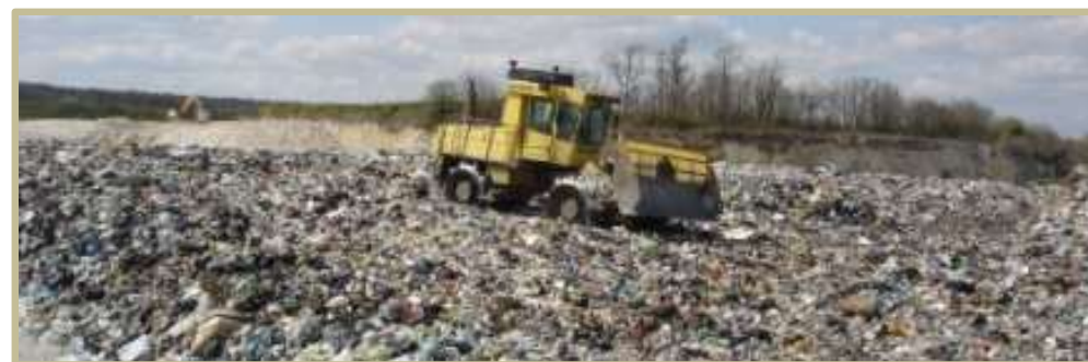
Casier de stockage à l'ISDND de Monflanquin (47)
